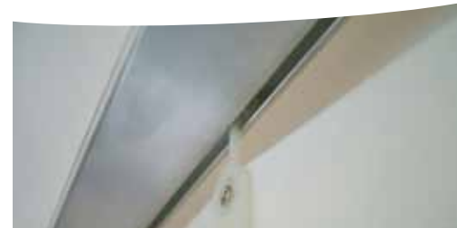
Befestigung der Seitenplanen mit Kunststoffgleitern im Kederprofil
